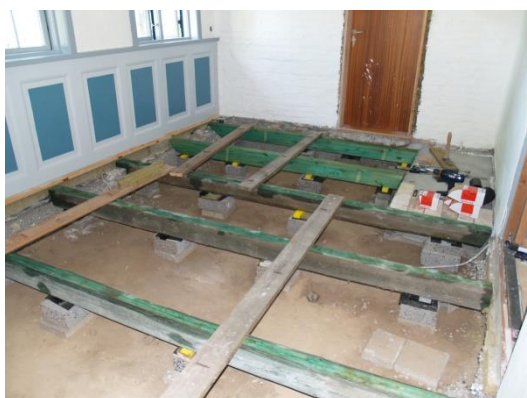
Lille stue. Paneler opsat. Strøer lagt. Der er klar til at udlægge isolering (leca og støbebatts mellem strøer).
