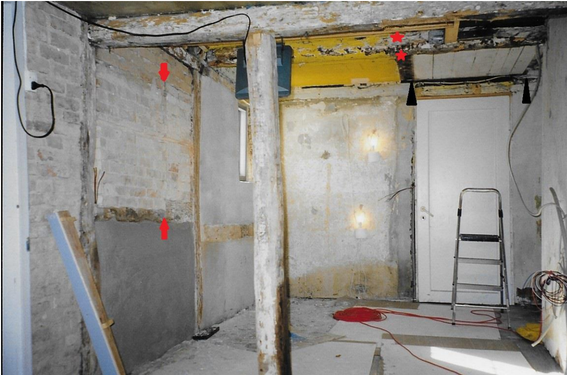
Sydende af gang efter stolpe (midt i billedet) er flyttet ca 75 cm til venstre. Røde pile: udmuret vindueshul i 6.fag; bemærk udhugning i løsholt. Sorte pilespidser: spor efter langsgående vægge i loft. Røde stjerner: gul farve også på bjælke i 7. binding.
