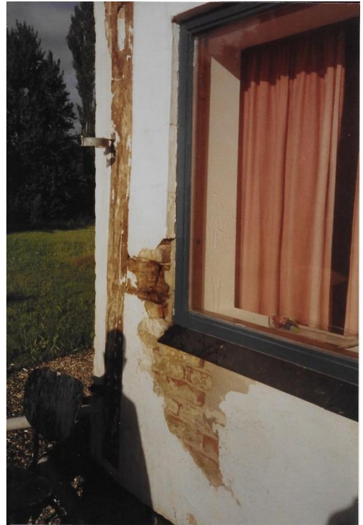
Vestside, 1. fag mod nord: Fritlagt overskåret løsholt i eg. Underfyldning delvist afrenset. Bemærk stolpe uden bindebjælke, da der er muret gavl udenpå gl. gavlmur.
