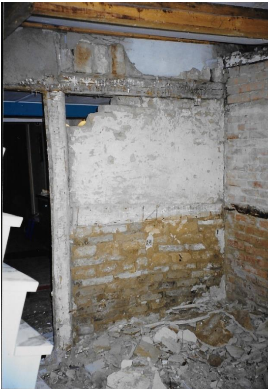
Rest af den gamle, oprindelige væg mellem bolig og stald, set fra gang. Øverst ubrændte sten, nederst brændte sten muret op i lermørtel. Bemærk de lodrette mursten ovenpå bjælken ved hævet loft i 6.fag.
