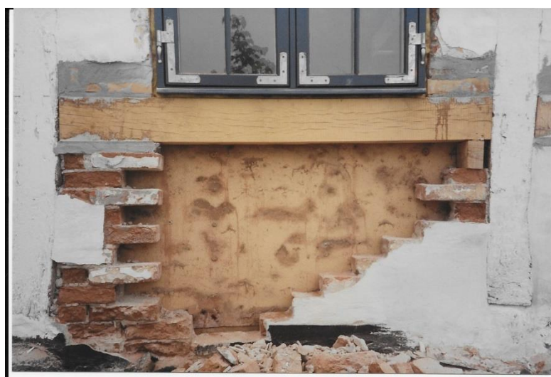
Vest, 4. fag. Ny løsholt isat med spiger og vinkelbeslag. Efter afrensning erstattes frostsprængte mursten med nyt murværk og der lægges murpap under hele fyldningen efter syldsten er sat i cementmørtel. Bemærk bagsiden af cellutex isoleringen, der var sømmet direkte på murstensvæggen.
