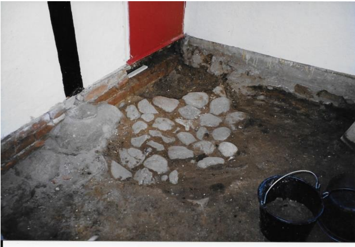
Gammel pigstensbelægning ca 30 cm under nuværende niveau. Ved restaurering er den bortrånede stolpeende erstattet med mursten.
