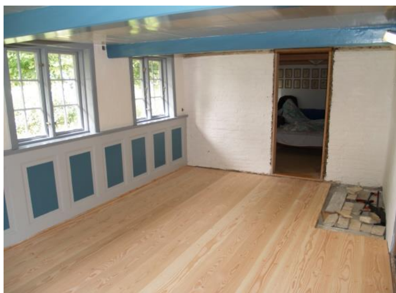
Lille stue. Gulv lagt. Paneler, loft og vægge færdigbehandlet. Stenunderlag til brændeovn er ved at blive lagt.
