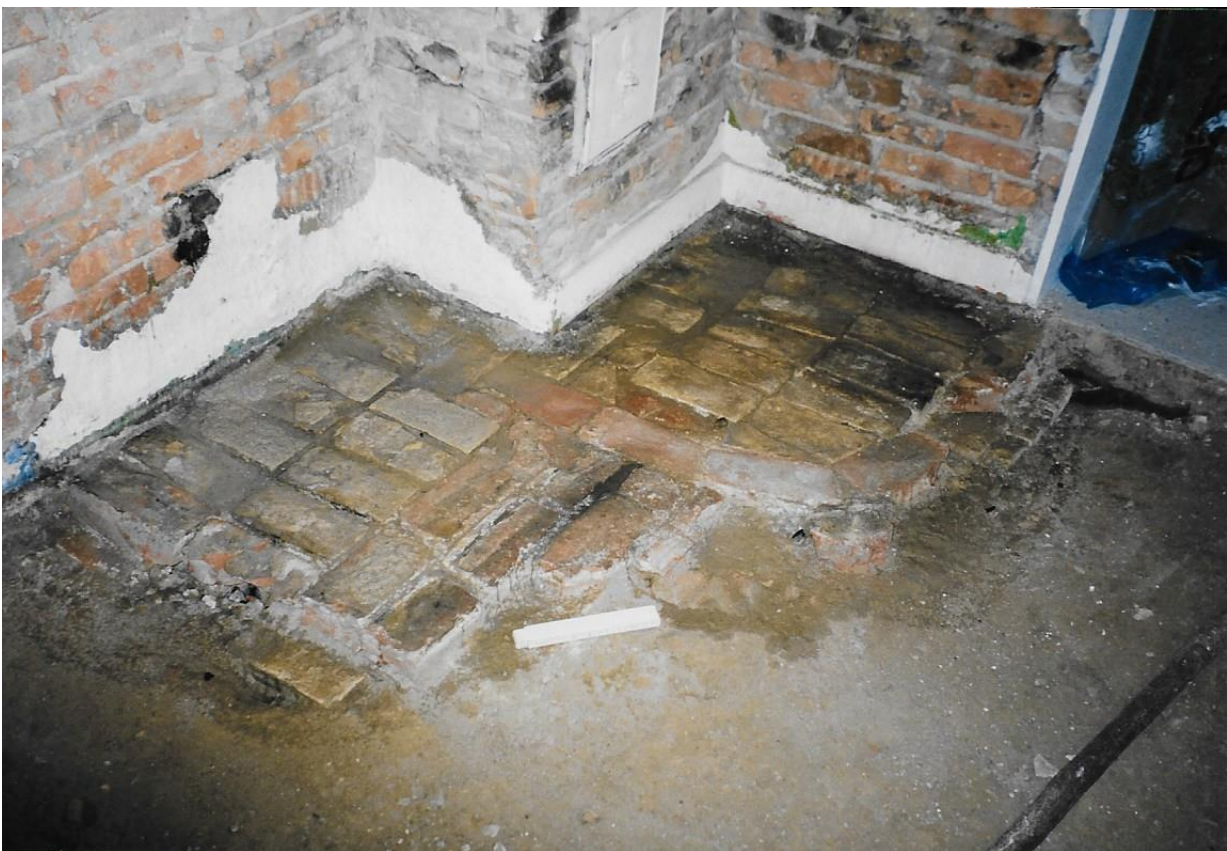
Belægning af mursten omkring skorsten. Det lerstampede gulv er bortgravet. Tommelstok angiver størrelsesforhold.
