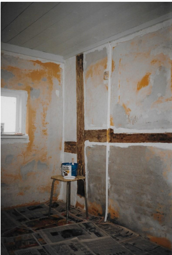
Vest. 3. stolpe fra nord. Forrådnnet stolpeende afhugget og stolpe kilet op med marksten.
