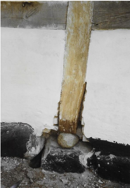
Vest. 3. stolpe fra nord. Forrådnnet stolpeende afhugget og stolpe kilet op med marksten.
